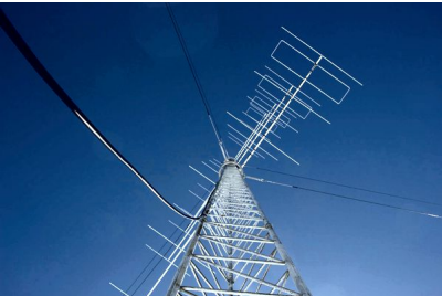
A 6 x 7el 50MHz WOS vertical stack at W7EL
